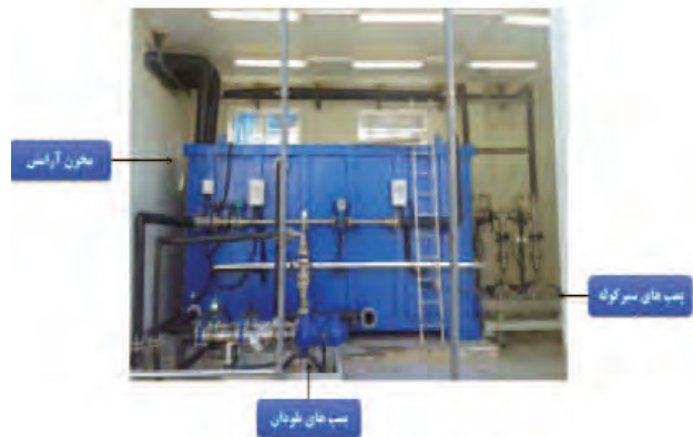
شکل ۶ مخزن آرامش و سیستم سیرکوله سامانه مدیا
